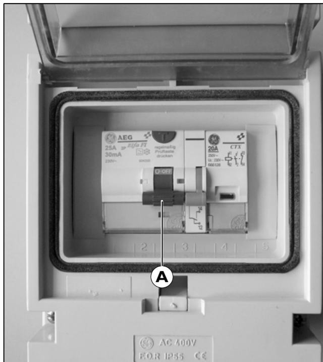
[405] RCD-Box: Fehlerstromschutzschalter (A) in Stellung OFF
