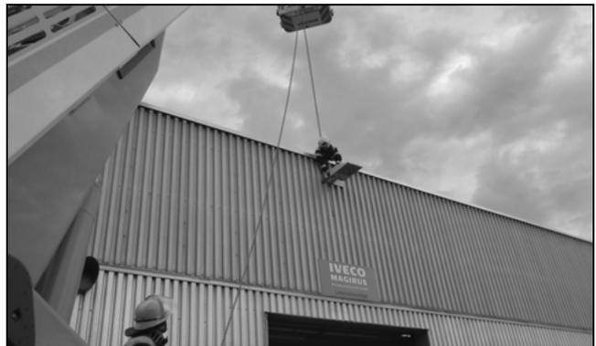
[11] Sicherung durch Auffangen bei Dacharbeiten
